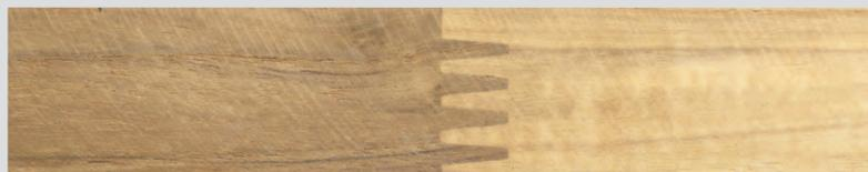
▲ Querschnitt Plattenaufbau bei keilgezinkter Verbindung
